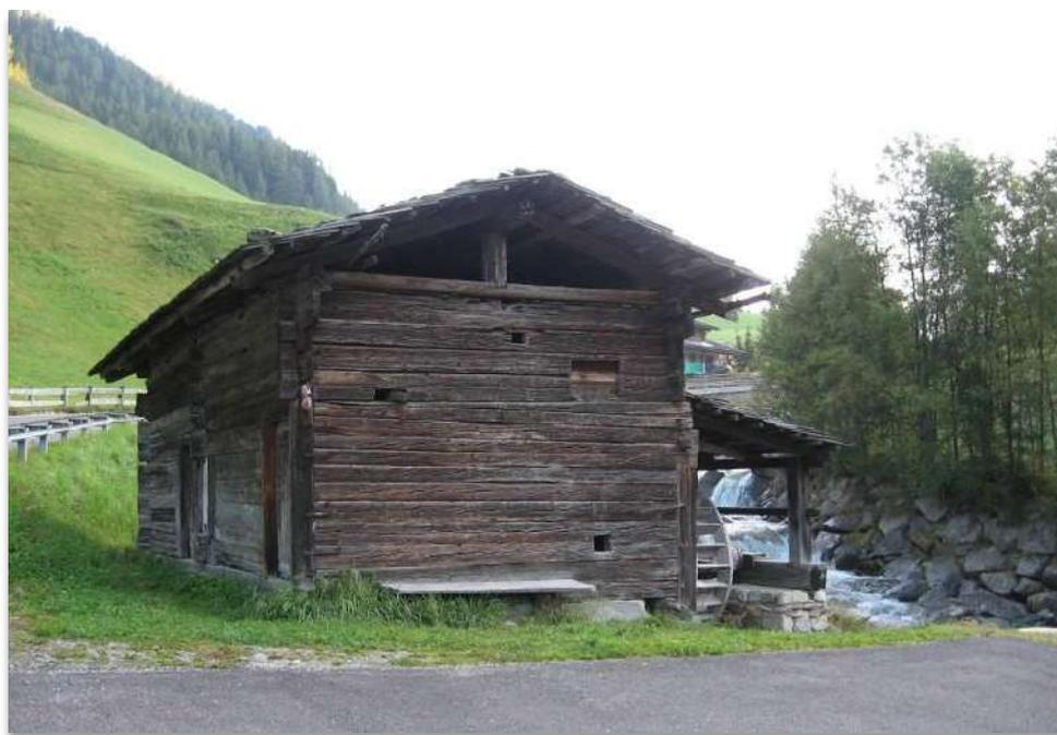
Ci si trova di fronte ad un antico mulino di legno in semplice costruzione a *blockbau* risalente al 1705. Esso era probabilmente uno dei pochi mulini privati appartenenti a contadini di maso che, grazie ad esso, potevano avere un ulteriore mezzo di sostentamento per la produzione di farine.
