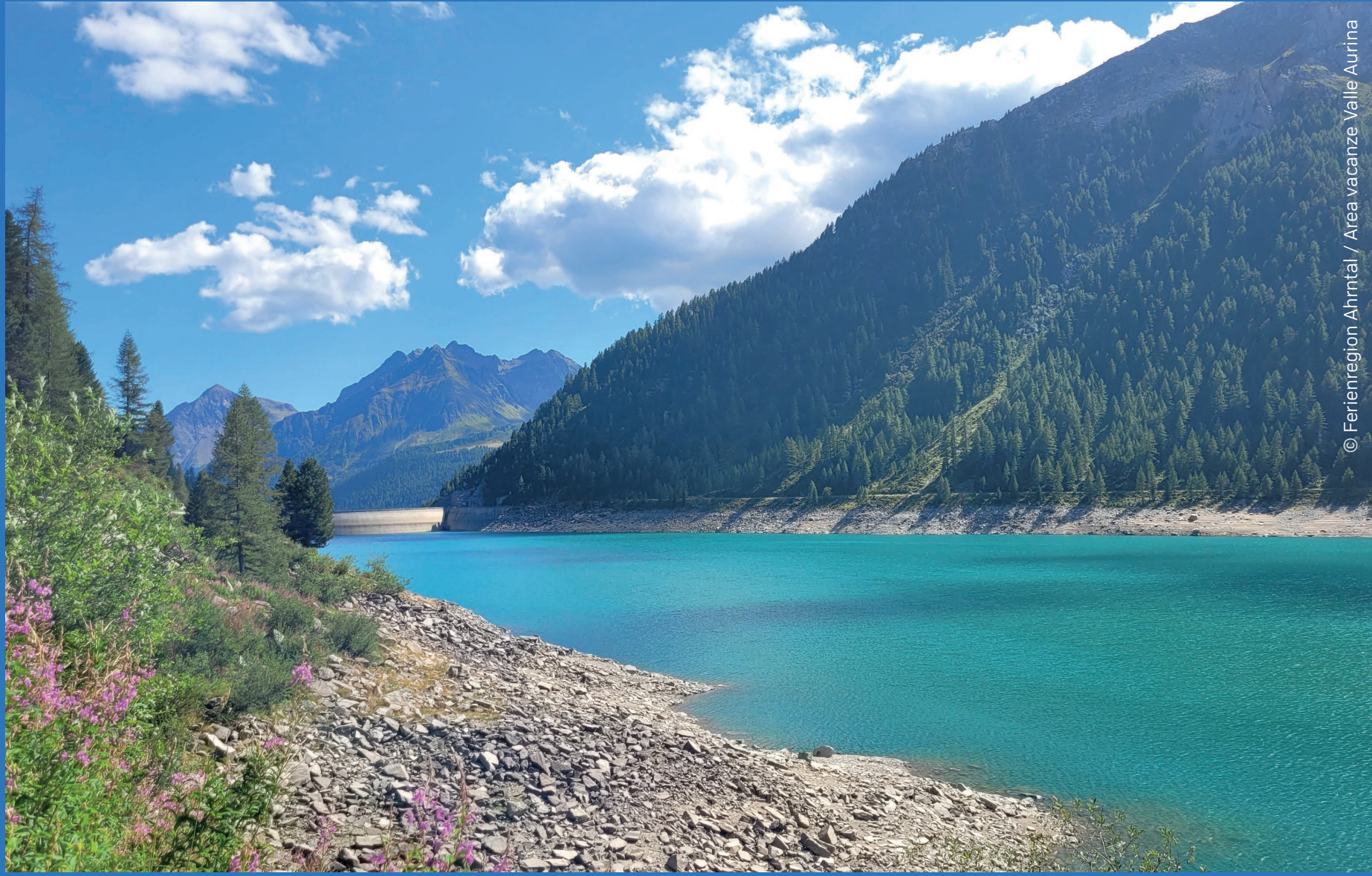
A Der Neves Stausee ist der nördlichste Stausee Italiens. Il lago di Neves è il bacino artificiale più a nord d'Italia.
