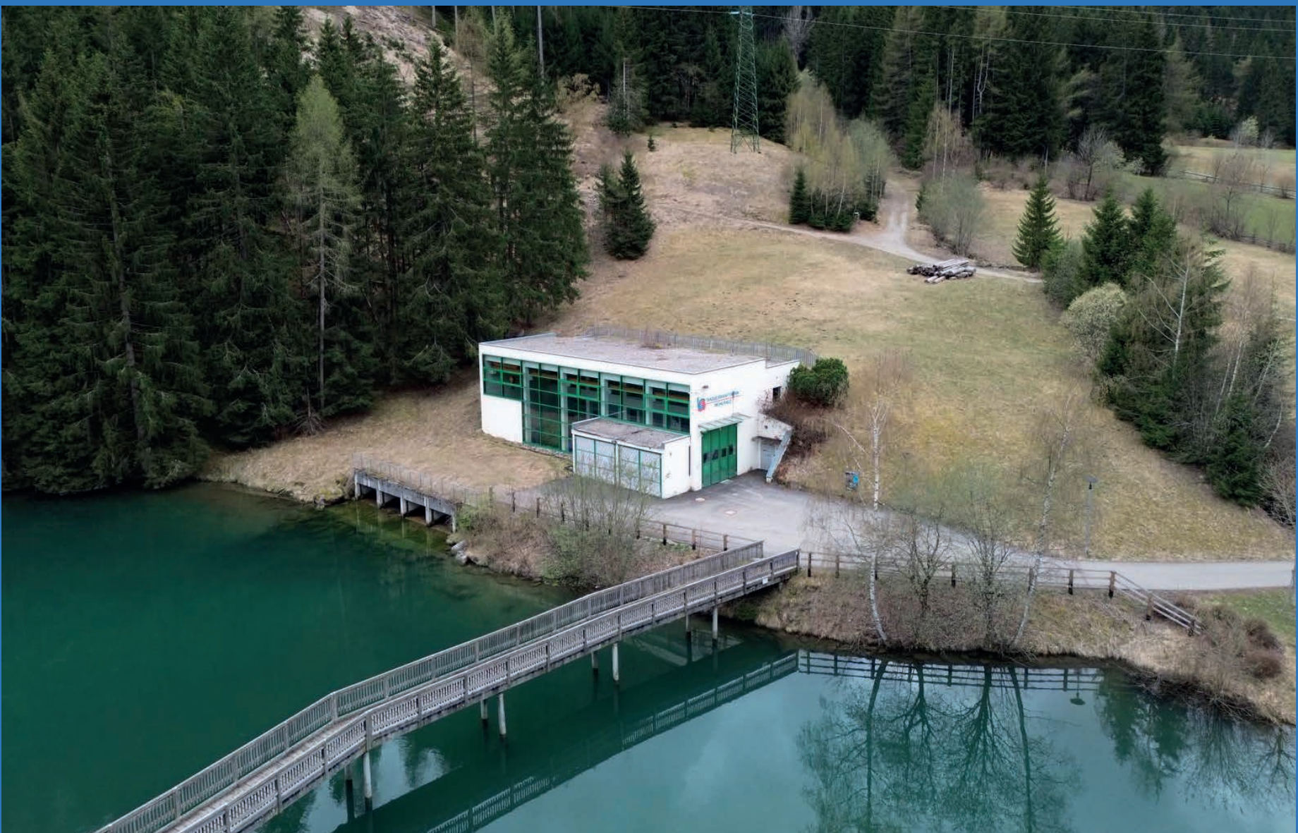
E Das Kraftwerk Mühlwald nutzt das Triebwasser aus dem Kraftwerk Lappach, um Strom zu produzieren. La centrale di Selva di Molini produce energia elettrica sfruttando l'acqua di scarico della centrale di Lappago.
