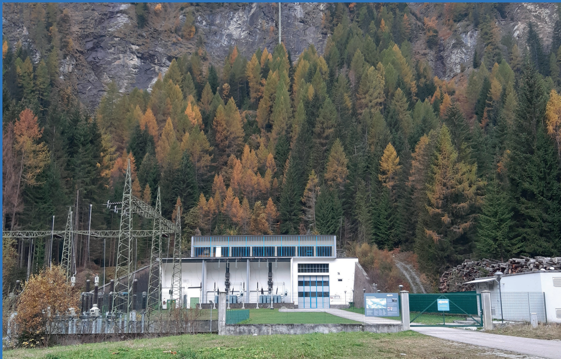
D Kraftwerk Lappach mit Umspannwerk. Oberhalb über die Felsen verläuft die Druckrohrleitung. Centrale di Lappago con sottostazione elettrica. Sopra, lungo le rocce, passa la condotta forzata.
