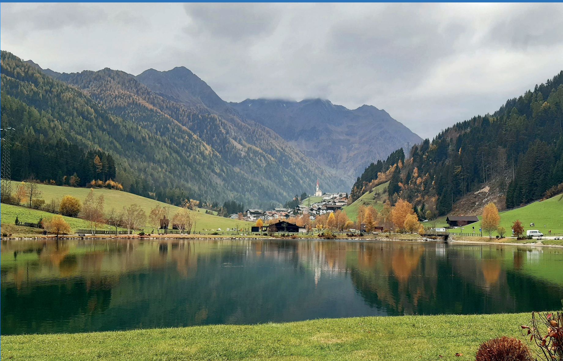
F Der Mühlwalder See: Erholungsraum und Staubecken für das Kraftwerk in Mühlen. Il lago di Selva di Molini: area ricreativa e bacino di raccolta per la centrale idroelettrica di Molini.
