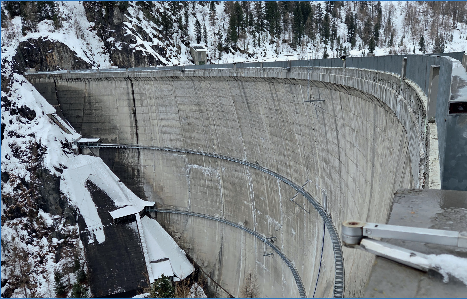
B Die Kuppelstaumauer ist mit 95 m Höhe die höchste Staumauer Südtirols. La diga a cupola con i suoi 95 m è la più alta dell'Alto Adige.
